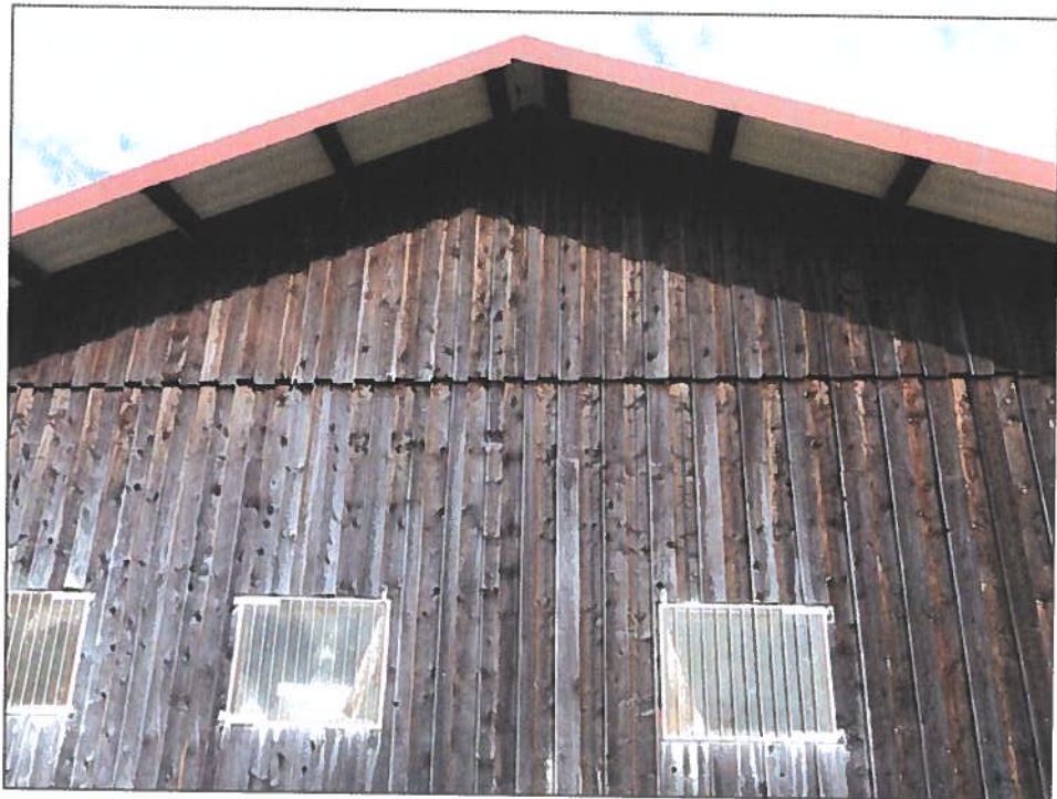
Abbildung 3: Lagerhalle mit Holzverkleidung (Quartierpotenzial für Spalten bewohnende Fledermausarten)
