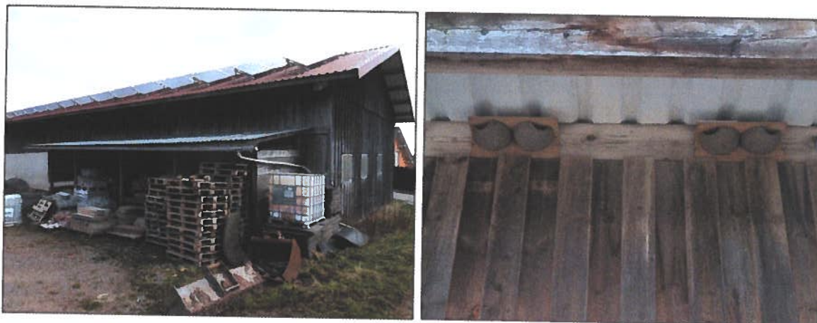
Abbildung 5: Lagerhalle mit Habitatpotenzial für Gebäudebrüter Unterhalb der Dachvorsprünge sind künstliche Nisthilfen für die Mehlschwalbe angebracht.
