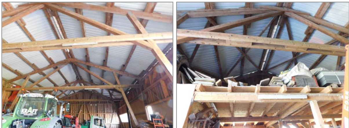
Abbildung 6: Lichte Gerätehalle mit Holzkonstruktion und Wellblechdach (Fotos: H. Turni, August 2021)
