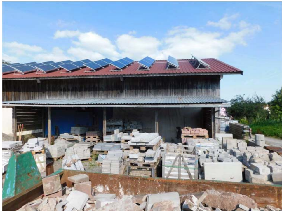
Abbildung 4: Gerätehalle mit Solardach, Westansicht (Foto: H. Turni, Juli 2021)
