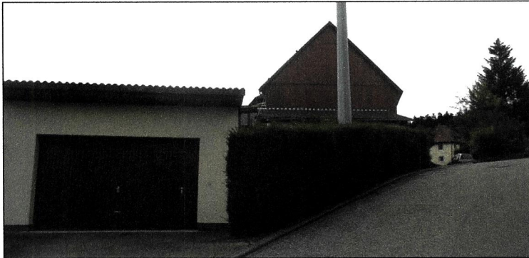
Abbildung 4 Freistehendes Garagengebäude (links) und Gebäudekomplex aus Wohnhaus und Scheunenanbau (Hintergrund).
